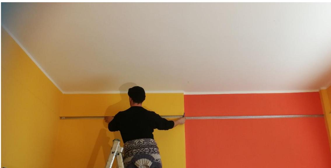
Con l'ausilio di due pinze **modellare lievi ondulazioni** della barra angolare muovendo gli attrezzi in senso contrapposto tra di loro
